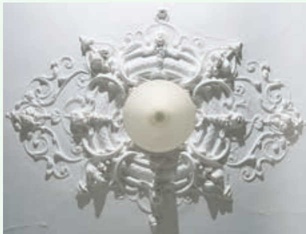
afb. 5 Detail centrale deel stucplafond.
