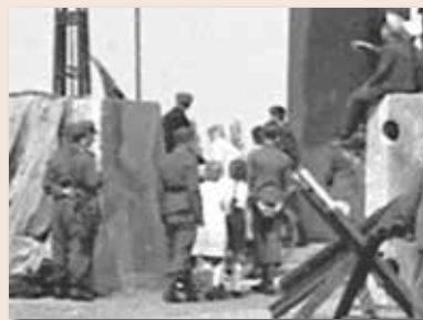
afb. 1 Brug met stalen balkversperringen.
